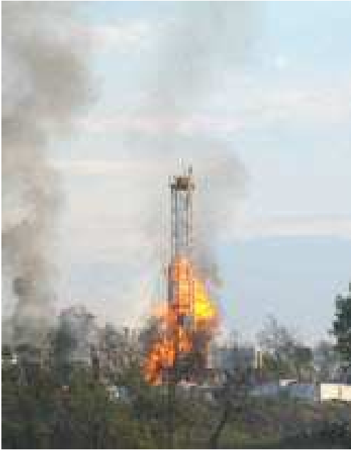
Photo : incendie sur un puits d'extraction USA
