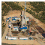
Deux tours de forage sur un site où 10 puits ont déjà été forés (Colorado).
