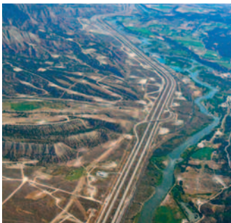
Site de forage de part et d'autre de la rivière Colorado.
