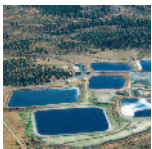
Site commercial de bassins d'évaporation de fluides de fracturation.
